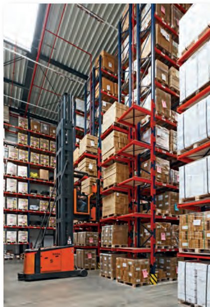
L'entrepôt de grande hauteur
